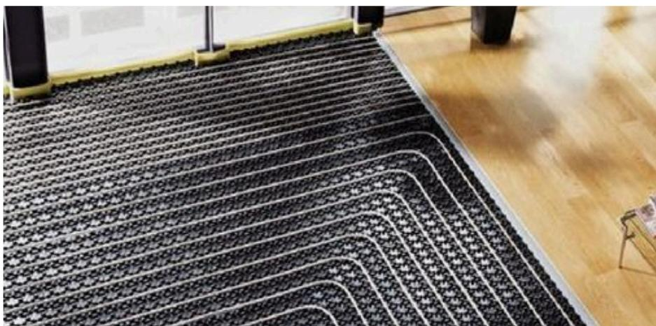
Ogni appartamento sarà dotato di un impianto di riscaldamento a **pannelli radianti a pavimento** per ogni locale, con produzione di acqua calda sanitaria centralizzata. L'energia primaria sarà generata da una pompa di calore aria/acqua elettrica e da caldaie a condensazione alimentate a gas metano.
